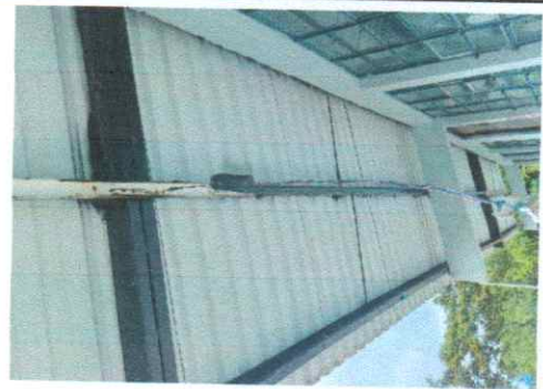
Foto 4: Reparacion de sistema eléctrico
