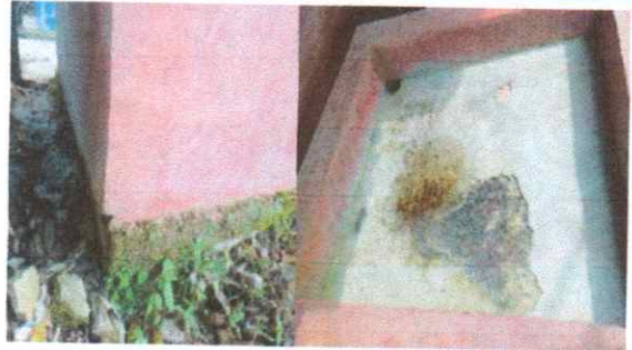
Foto 2: Sustitución de pila de cemento de un lavadero
