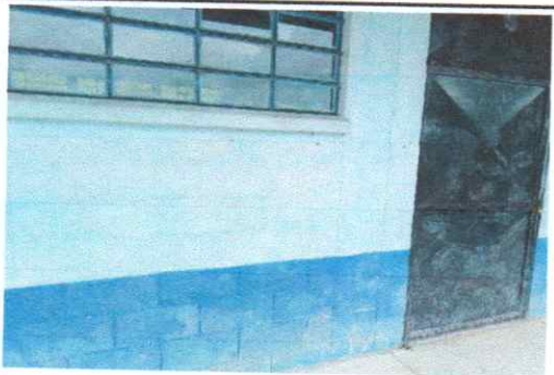
Foto 5: Pintura en aulas exteriores e interiores
