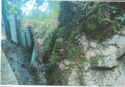
Foto1: Reparación de muro de concreto
